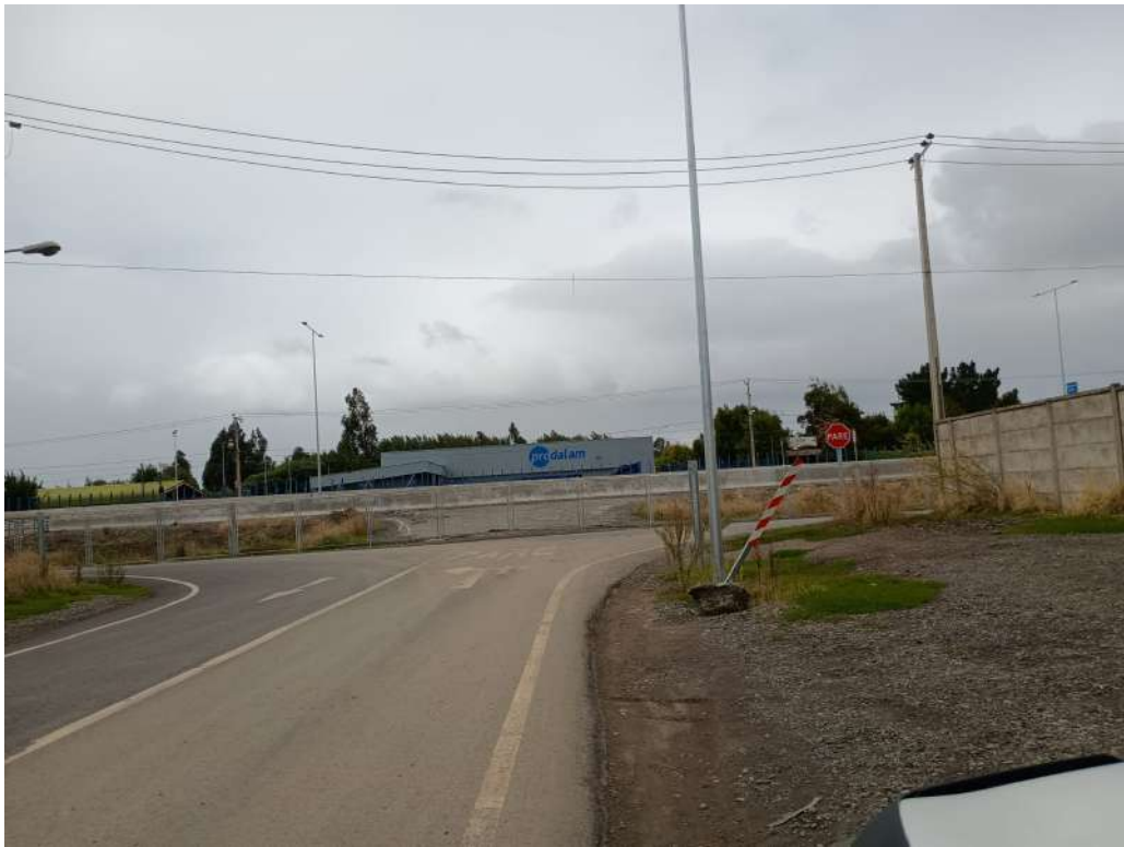
Obstaculización de la vía S3 por obra autopista concesionada.
